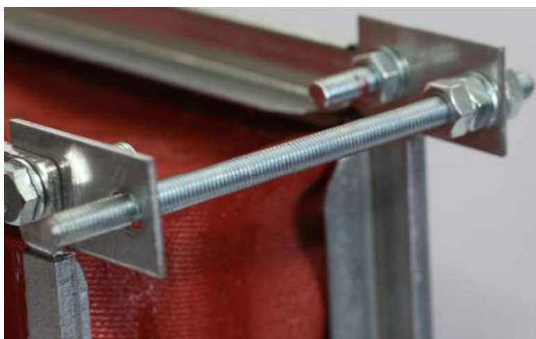
Fot.7. Widoczną na zdjęciu nr 6 podkładkę należy usunąć z kompensatora by stan zgadzał się z fotografią .
