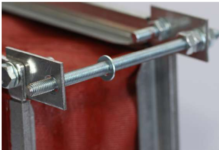
Fot.6. Wewnętrzną nakrętkę w czterech narożnikach należy przekręcić do przeciwległych narożników by stan zgadzał się z fotografią .
